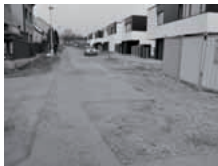
Rekonstrukce komunikace na Dolině
