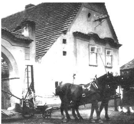
Statek Kratochvílův č. 29, z doby předbělohorské, od r. 1998 tu sídlí stavební společnost Pentas, která objekt citlivě zrakonstruovala
