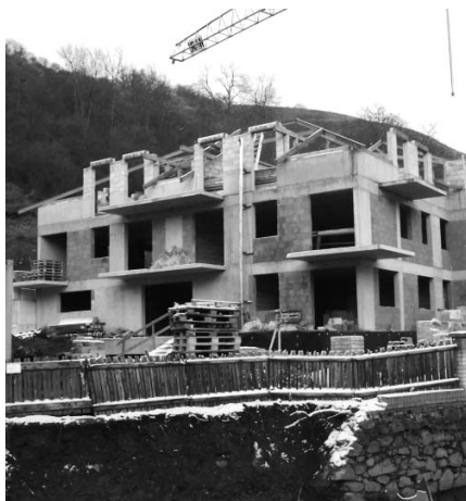
Stavební práce rychle pokračují
